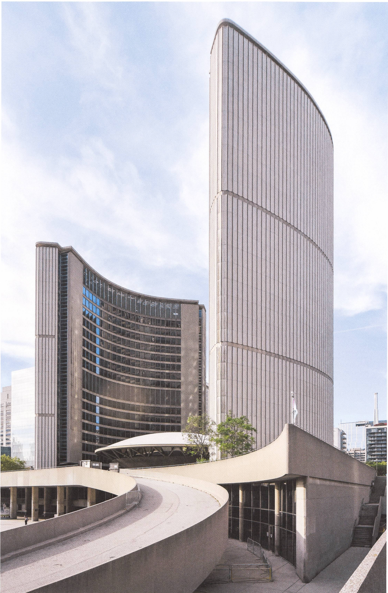
Eine Rampe führt in einer ausladenden Kurve auf den Sockelbau und verankert auf diese Weise die geschwungenen Gebäude am Platz.
