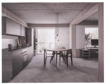
Das Holzskelett trägt Betonverbunddecken.
