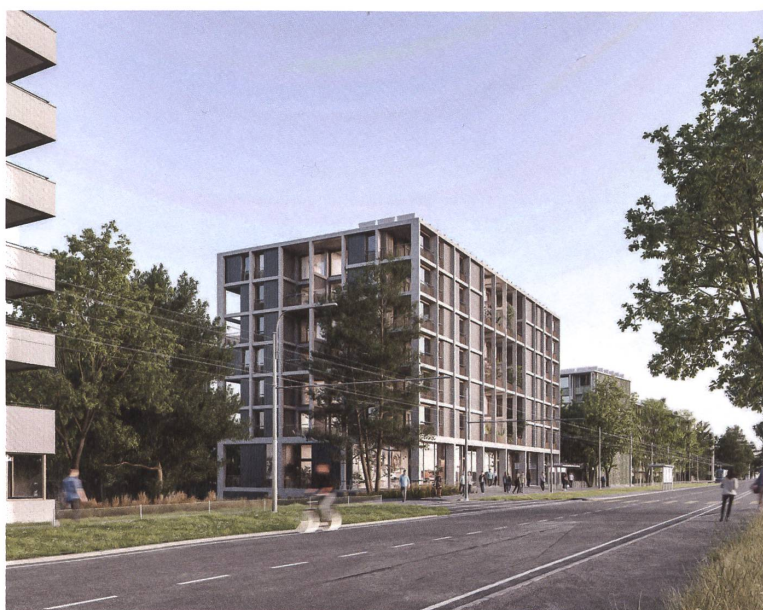
Das Haus 6 ist ein Betonbau mit Photovoltaikfassaden.
