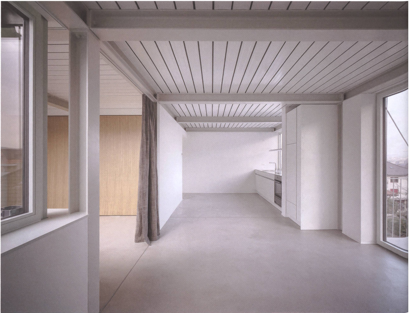
Die Kleinwohnungen sind offen zониert und flächeneffizient. Das Stahlskelett und die Blechdecken sind allerorts präsent.
