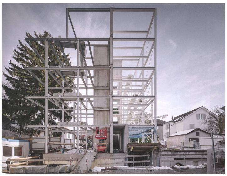
$Am\ Herbstweg\ in\ Z\"{u}rich\ adaptieren\ Graser\ Troxler\ Architekten\ ein\ Stahl-Beton-Verbundsystem\ aus\ dem\ Industriebau\ f\"{u}r\ eine\ Wohnnutzung.$
