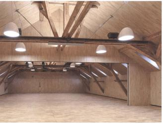
Die beiden Singsäle sind als hölzernes Futteral in die Dachkonstruktion integriert.
