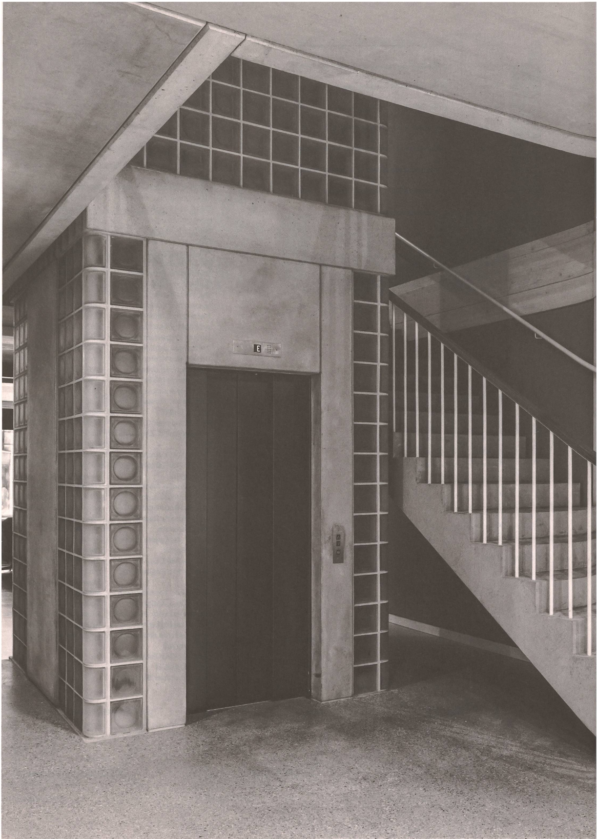
Der Liftschacht im Treppenhaus mit Glasbausteinwänden.
