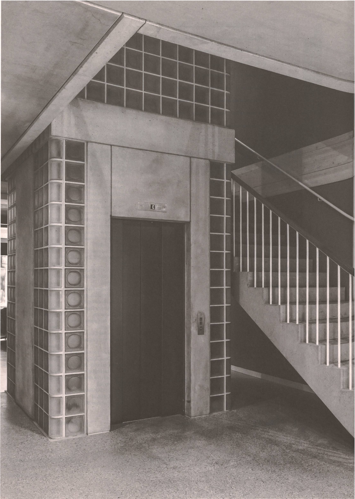
Der Liftschacht im Treppenhaus mit Glasbausteinwänden.
