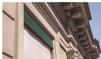
Die Abdeckbleche mit Vertiefung prägen das Fassadenbild mit.
