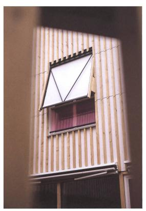
Der Sonnenschutz ist zwischen die schmalen Holzelemente eingepasst.
