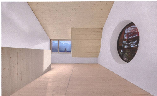
Untergeschoss und Geschossdecken sind aus T3S-Brett- sperrholz gebaut.
