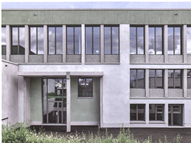
Das Eisteinmauerwerk und die Betonelemente der Fassade tragen sich selbst.
