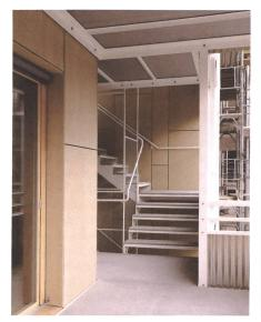
Die Treppe liegt als feine Stahlkonstruktion im Aussenbereich.
