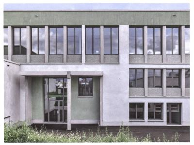
Das Einsteinmauerwerk und die Betonelemente der Fassade tragen sich selbst.
