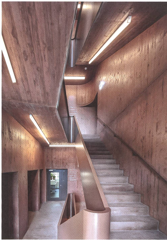
Rot eingefärbter Beton bestimmt das Bild im Treppenhaus.
