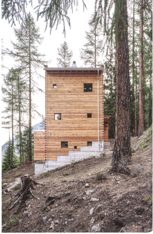
Der neue Turm dient dem Hüttenteam als Unterkunft – ein präzis geplanter und gefügter Strickbau aus Lärchenholz.
