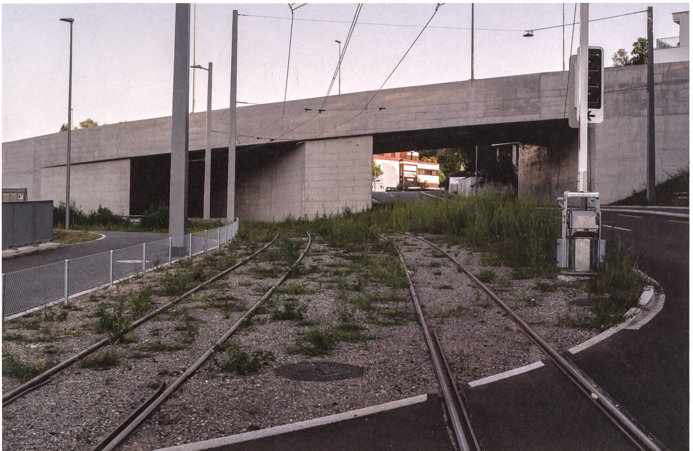
Killwangen: Bei der Überwerfung Zürcherstrasse unterfahren die Limmattalbahn und die Bahnhofstrasse die Zürcherstrasse. →
