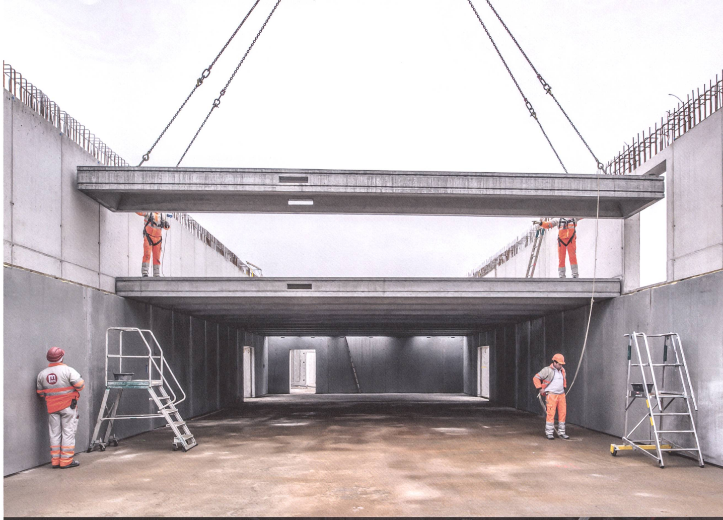
Versetzen von Deckenelementen Anfang 2018.
