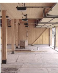
Die Bodenplatten sind wiederverwendet.
