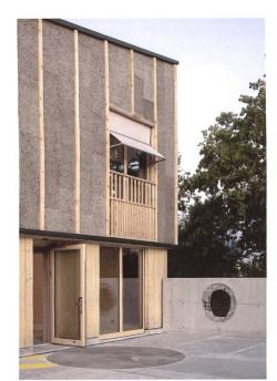
Fassade mit Fichtenholz und Korkdämmplatten.
