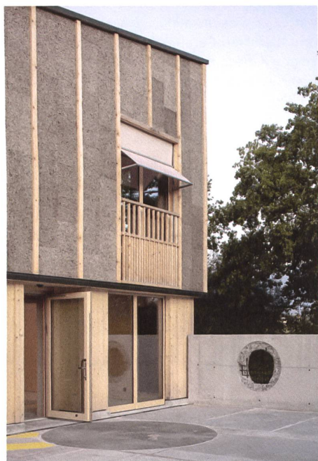
Fassade mit Fichtenholz und Korkdämmplatten.
