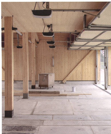
Die Bodenplatten sind wiederverwendet.
