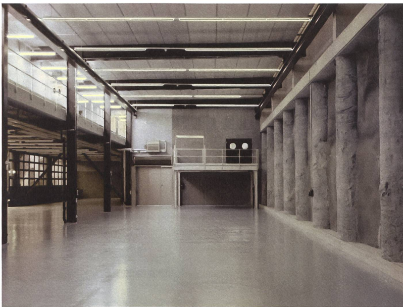
Die mächtige Hangsicherung ist sichtbar und prägt die zweigeschossige Halle.
