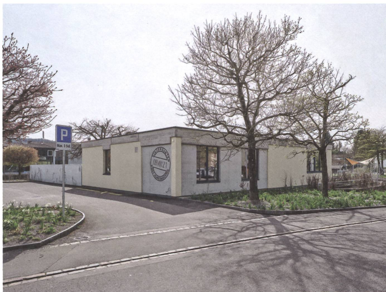
Den ehemaligen Kundenzugang haben die Architekten mittels zweier Betonmauern geschlossen.
