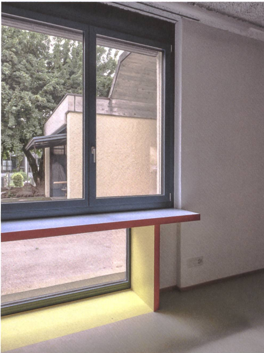
Dank der neu verglasten Brüstung sehen auch die Kleinen hinaus.
