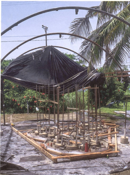
Improvisierte Gussformen zur Herstellung der Betonplattformen, die als Fundamente des Kunstriffs dienen.
