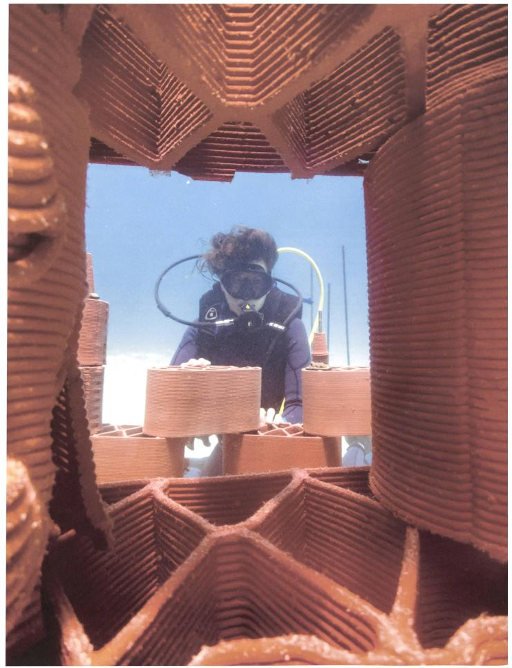
Die Tonbausteine stecken wie Legosteine ineinander. Je nach Topologie und Strömung wird die Riffarchitektur an die Bedingungen unter Wasser angepasst.
