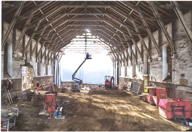
Das Dach wurde bei der Stirnfassade geöffnet, um die Kuben für die Nebenräume zu betonieren. Foto: Luca Zanier
