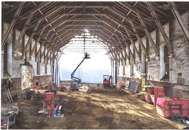
Das Dach wurde bei der Stirnfassade geöffnet, um die Kuben für die Nebenräume zu betonieren. Foto: Luca Zanier
