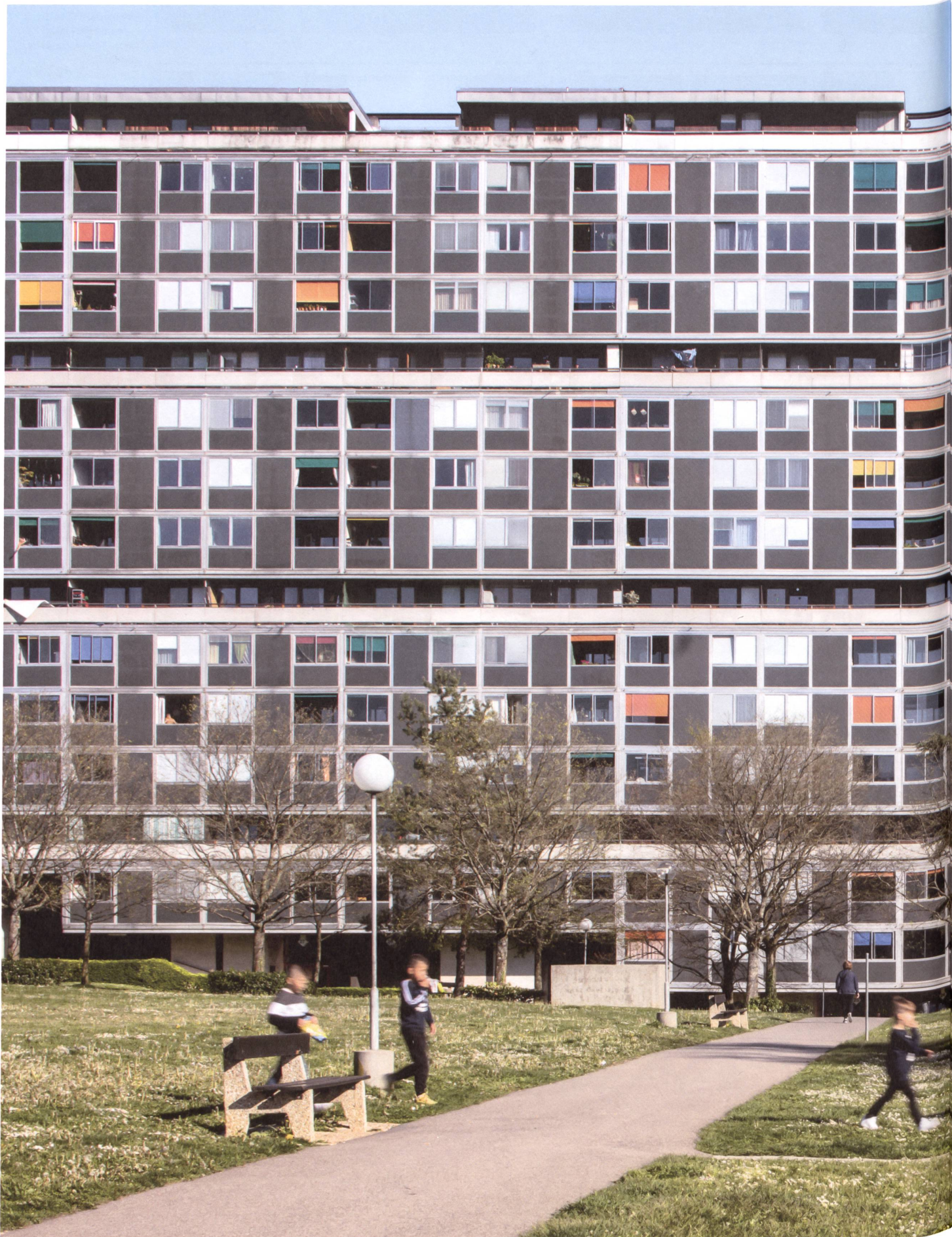
Unsichtbar bleiben war das Ziel: Die sanierten Abschnitte der Curtain-Wall-Fassade lassen sich von den nicht sanierten kaum unterscheiden.
