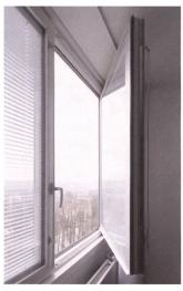
Zweischichtiges System: Die äusseren Alufenster sind erhalten geblieben. Die Holzfenster innen wurden durch neue mit Doppelverglasung ersetzt.
