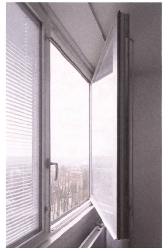
Zweischichtiges System: Die äusseren Alufenster sind erhalten geblieben. Die Holzfenster innen wurden durch neue mit Doppelverglasung ersetzt.
