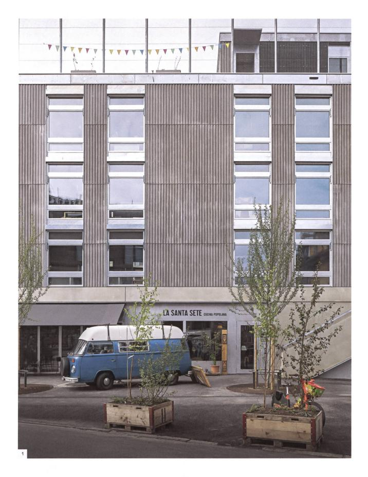
→ unklar. Unbeschichtete Platten finden sich im Dachsortiment von Eternit, nicht jedoch im Fassadensortiment. Bei Lagerhallen und Wohnbauten werden sie gern gewählt. Sie decken sogar das Dach der Erweiterung des Landesmuseums in Zürich.
