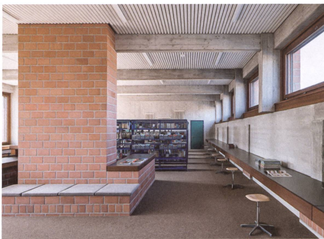
In der neuen Bibliothek wurde ein bestehender Schacht verlängert und zu einer Sitzgruppe ausgebaut.
