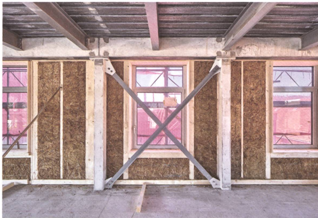
Materiali poveri: Die Fassade besteht aus Holz, Lehm und Stroh.
