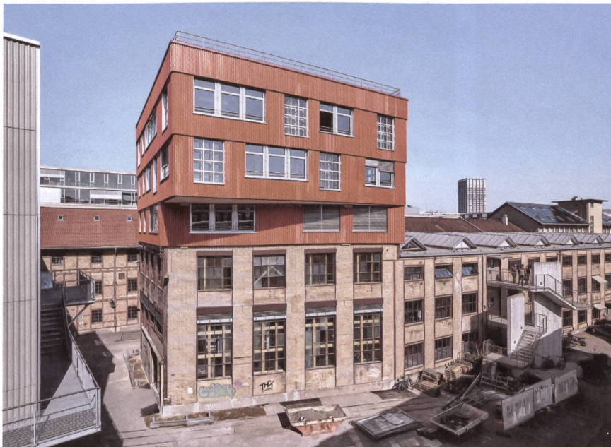
Grauenergie-Champion dank Wiederverwendung: Die Aufstockung in Winterthur nutzt, was sonst auf der Deponie landet.
