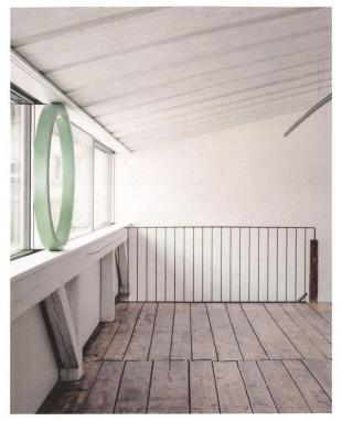
${\it Sch\"one St\"utze: Der gr\"unlich schimmernde Stahlring tr\"{a}gt.}$
