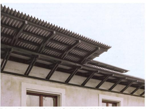
Klug konstruiert: Filigran spreizt sich das Dachwerk von der Fassade ab und faltet das Vordach auf.
