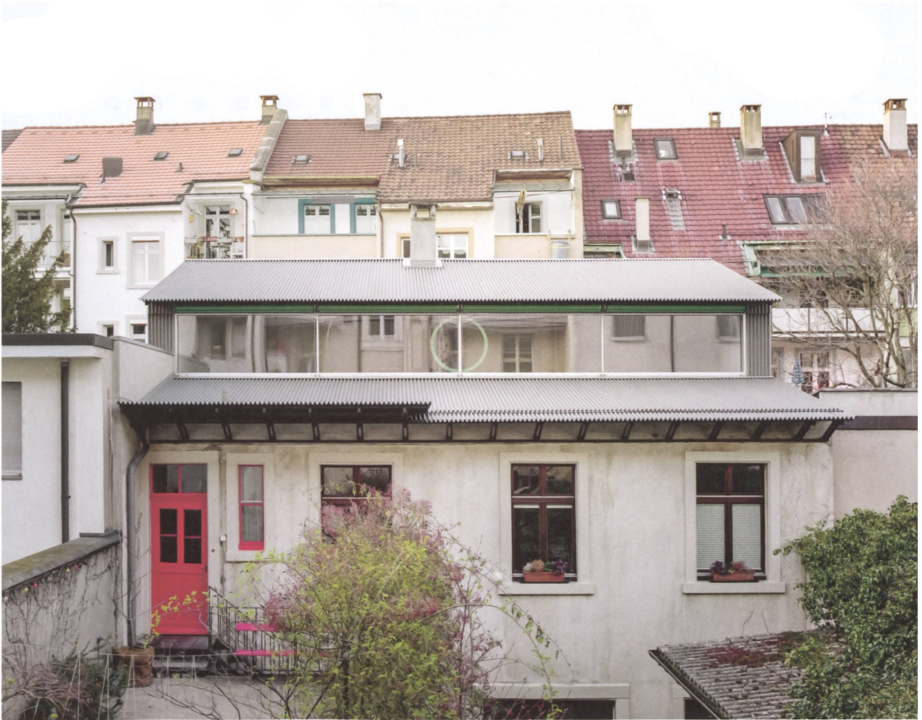
Aufgeklappt: Das Bandfenster bringt Licht in den einstigen Dachboden. Zinkblech erinnert an die industrielle Geschichte des Basler Hinterhofhauses.
