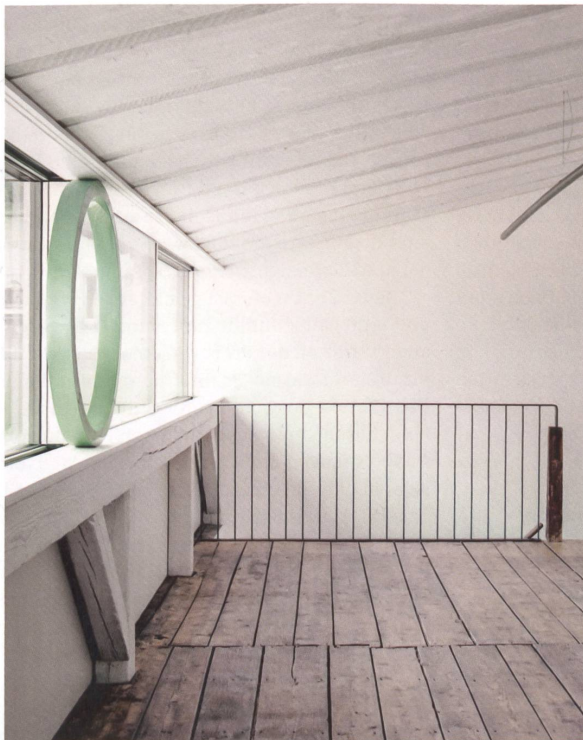
Schöne Stütze: Der grünlich schimmernde Stahlring trägt.
