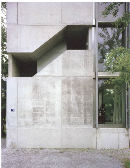
Das betonierte Treppenhaus gibt dem Gebäude Halt. | La cage d'escalier en béton donne un ancrage solide au bâtiment.
