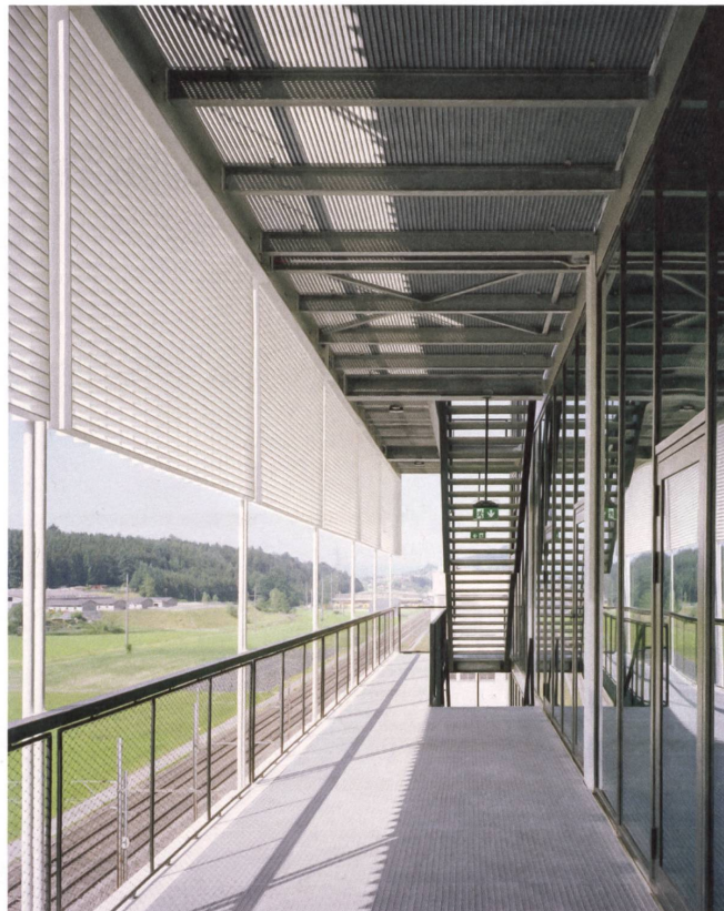
Die Fassade ist Klimaschicht, Fluchtweg und Aufenthaltsraum. | Ici, la façade sert à la fois de protection climatique, de voie d'évacuation et d'espace de pause.
