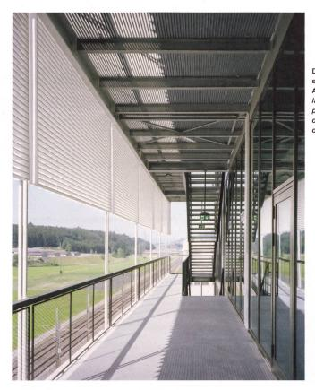
Die Fassade ist Klimaschicht, Fluchtweg und Aufenthaltsraum. I Ici, Ia façade sert à Ia fois de protection climatique, de voie d'évacuation et d'espace de pause.
