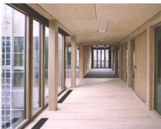
Die Holzstützen sind leicht konisch geformt.
