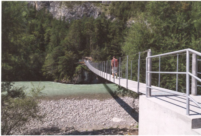
Dank der Vorspannung wirken die Betonelemente wie eine einzige Platte.
