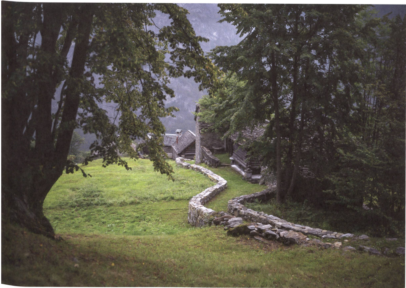
Mehrere Hundert Meter lange Trockenmauern werden Abschnitt für Abschnitt instand gestellt.
