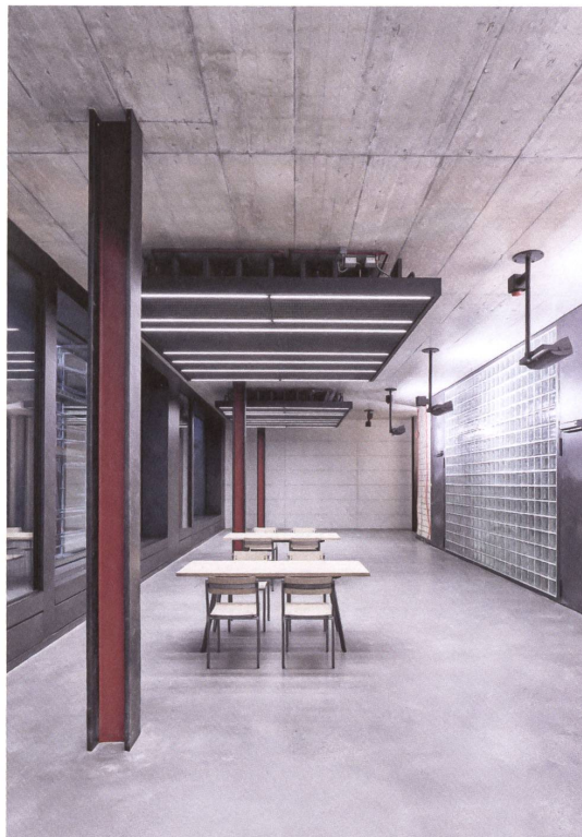
An den Decken fassen Heiz-Kühl-Paneele und Stahlgebilde die Haustechnik zusammen. An Stützen und Leitungen setzen Farben Akzente.
