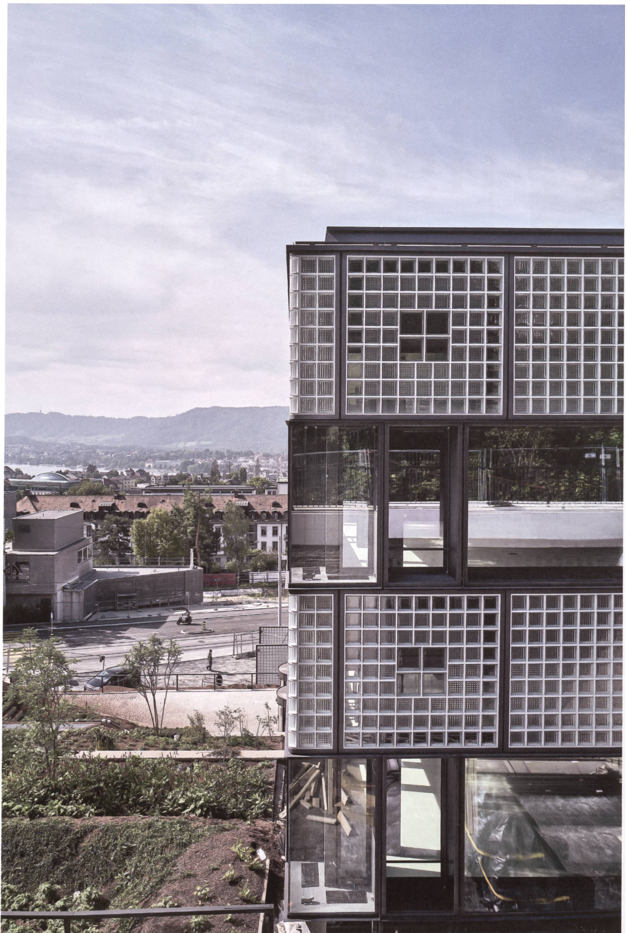
Das Relief, unterschiedlich grosse Glasbausteine und balancierte Proportionen machen die vermeintlich harte Fassade des Zürcher Laborbaus leicht und lebendig.
