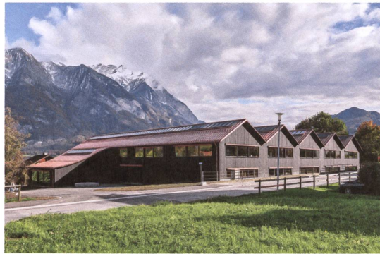
37 Das Sheddach vereint Turnhalle, Primarschule und Kindergarten.
