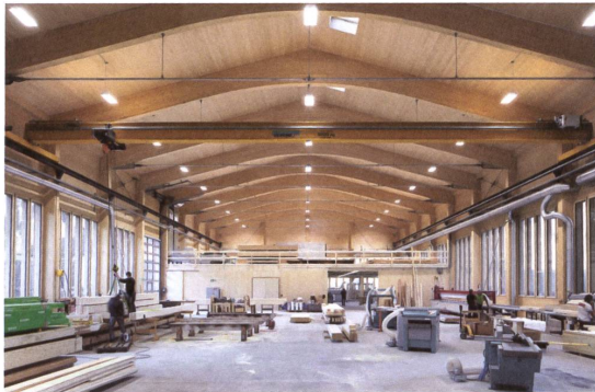
Dank Zugkabeln sind die Bogenbinder über der Zimmereihalle besonders schlank.
