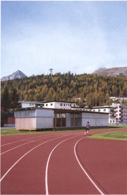
40 Der Pavillon ist vom Grundstein bis zur letzten Schraube auf die Montage ausgerichtet.
