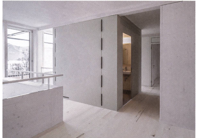
35 Ein Modul nimmt das Bad auf und versorgt die Wohnungen in Horw mit Frischluft.
