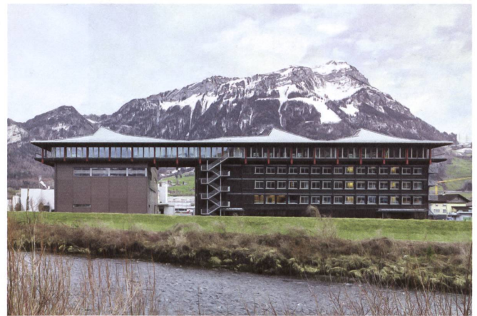
31 Das Dachgeschoss verbindet den Neubau mit dem bestehenden Produktionsgebäude von Felchlin in Ibach.
