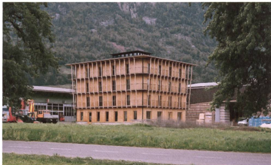
32 Das Bürohaus steht neben der Werkhalle von Küng in Alpnach.
