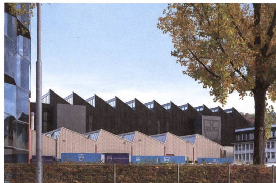
Das Sheddach sucht den Anschluss an die Nachbarschaft.
