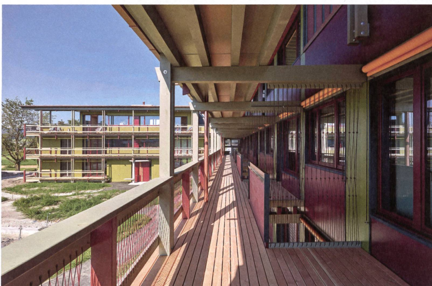
Mit Farbe und konstruktiver Vielfalt vermittelt die Wohnüberbauung Moos zur ländlich geprägten Umgebung.
