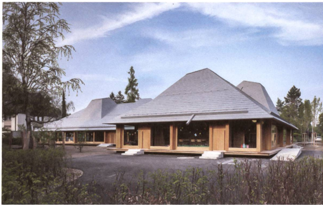
22 Ein expressiv geformtes Dach aus Aluminiumblech schützt den Holzbau darunter.
