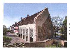
Die mittelalterliche Bruchsteinmauer des Landenberghauses in Greifensee haben die Architekten mit Sandsteinguadern ergänzt.
