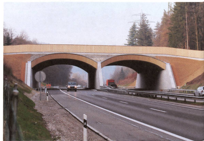
25 Mit der Wildtierüberführung bei Suhr stösst der Holzbau in neue Sphären vor. Foto: Astra
