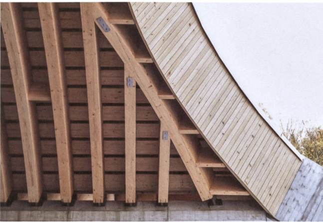
25 156 Holzträger führen über die Autobahn. Foto: Nils Sandmeier
