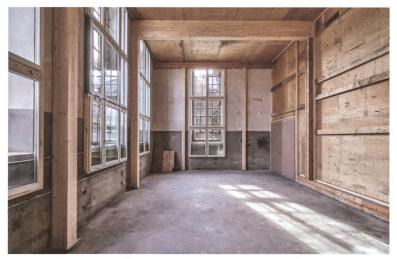
26 Die Künstlerateliers im alten Gaswerk in Schlieren bestehen aus wiederverwendeten Bauteilen.
