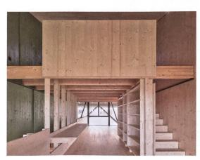
Alle Elemente von der Treppe bis zum Regal sind aus Dreischichtplatten konstruiert.
