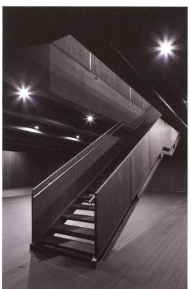
23 Die Decken zwischen manchen Balken können entfernt und die Treppen verschoben werden.
