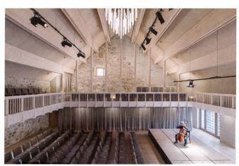
Das Dach ruht auf der betonierten Galerie, die wiederum die alten Mauern stabilisiert.
