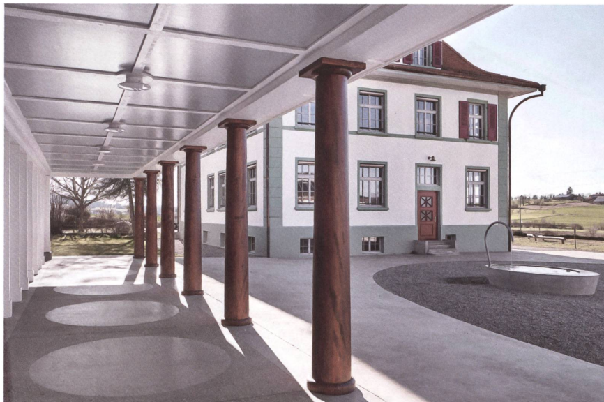
16 Stützen aus Massivholz suchen den Anschluss an das alte Schulhaus in Seedorf.
