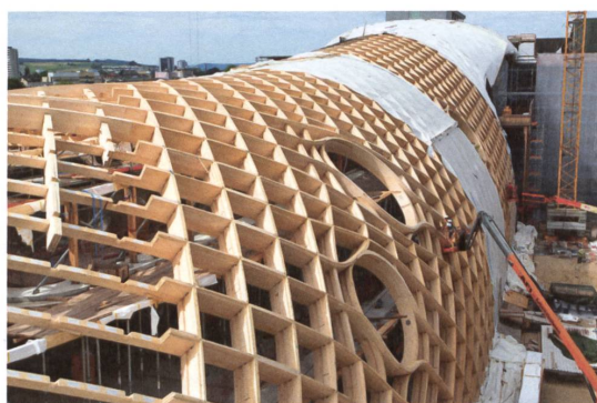
Die Dachkonstruktion besteht aus 4600 unterschiedlichen Elementen.
