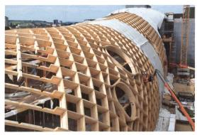
Die Dachkonstruktion besteht aus 4600 unterschiedlichen Elementen.
