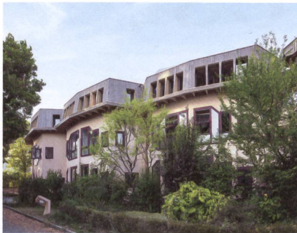
12 Vers l'extérieur, la surélévation évoque une couronne.
