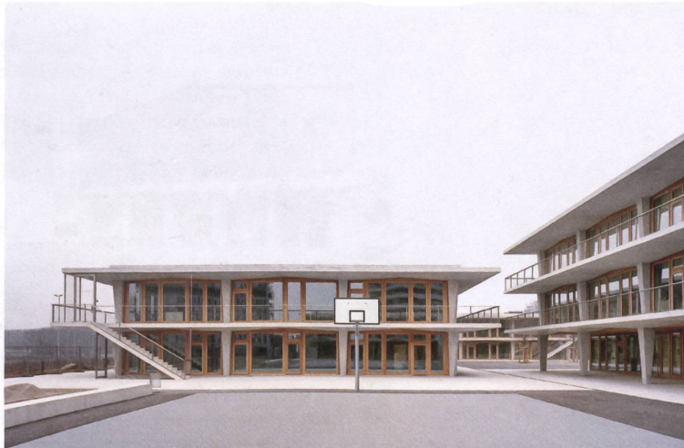
Derrière les avant-toits et coursives en béton, tout est construit en bois.
