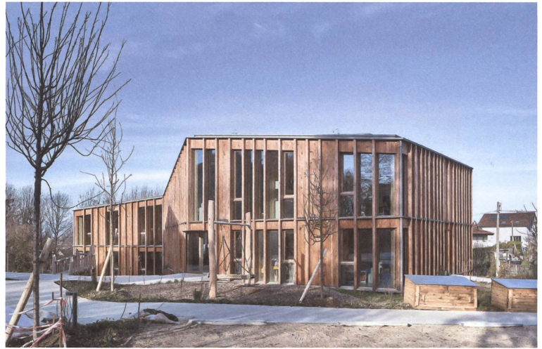
10 Les façades de la nouvelle crèche de Renens se composent de mélèze et d'épicéa.
