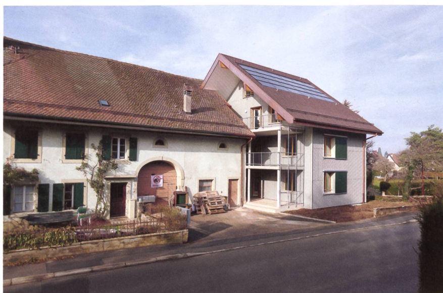
Der Neubau, auf die Baulinie gesetzt, tritt hinter dem Bestand hervor.
