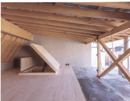
Halb zu, halb offen: Der unbeheizte Dachraum ist das Herzstück der Aufstockung.
