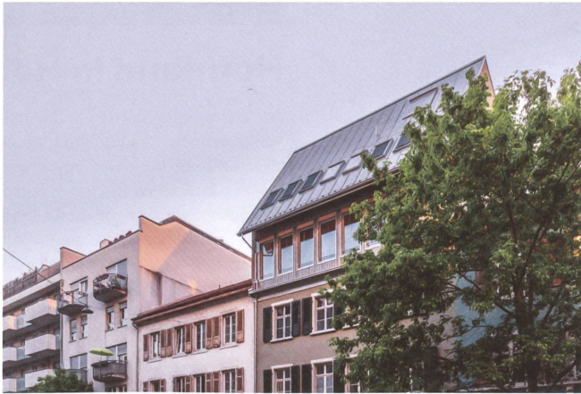
Charmant schlicht: das metallene Falzdach vor dem Fernheizkraftwerk.
