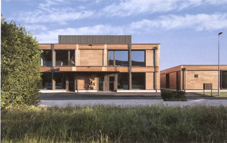
Eine kräftige Erscheinung: die zweigeschossige Tagesbetreuungsstätte und der niedrige Kindergarten.
