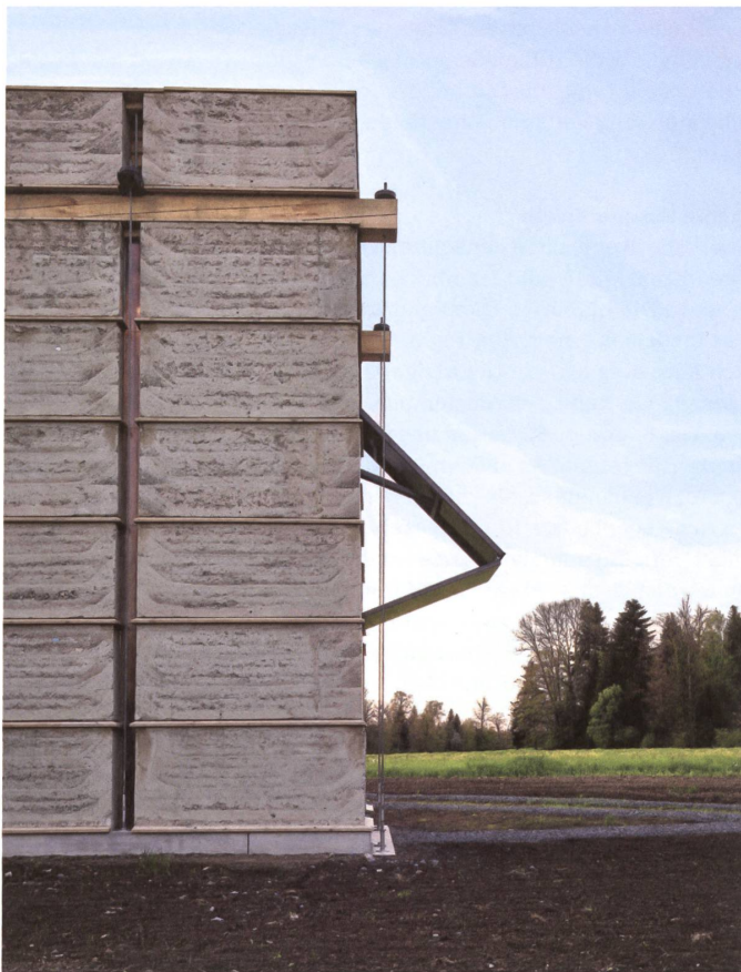
Vorspannkabel in der Fassade setzen die Stampflehmelemente unter Druck, um die Erschütterungen aufzunehmen.
