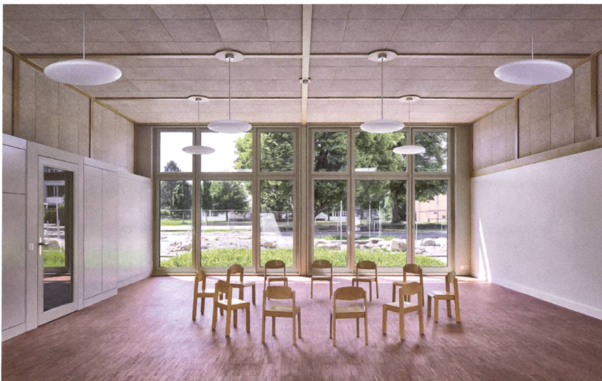
Die Gruppenräume des Kindergartens sind mit einer schmunken Haube aus Akustikplatten ausgestattet.
