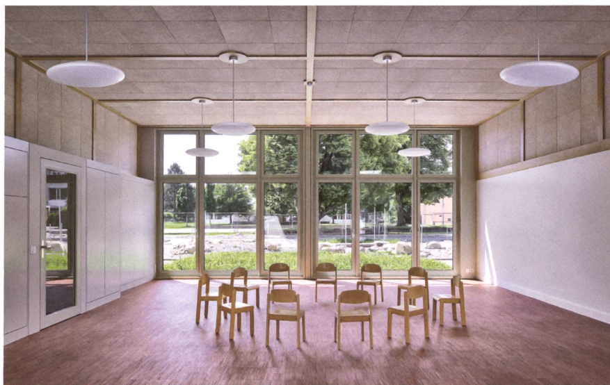
Die Gruppenräume des Kindergartens sind mit einer schmucken Haube aus Akustikplatten ausgestattet.
