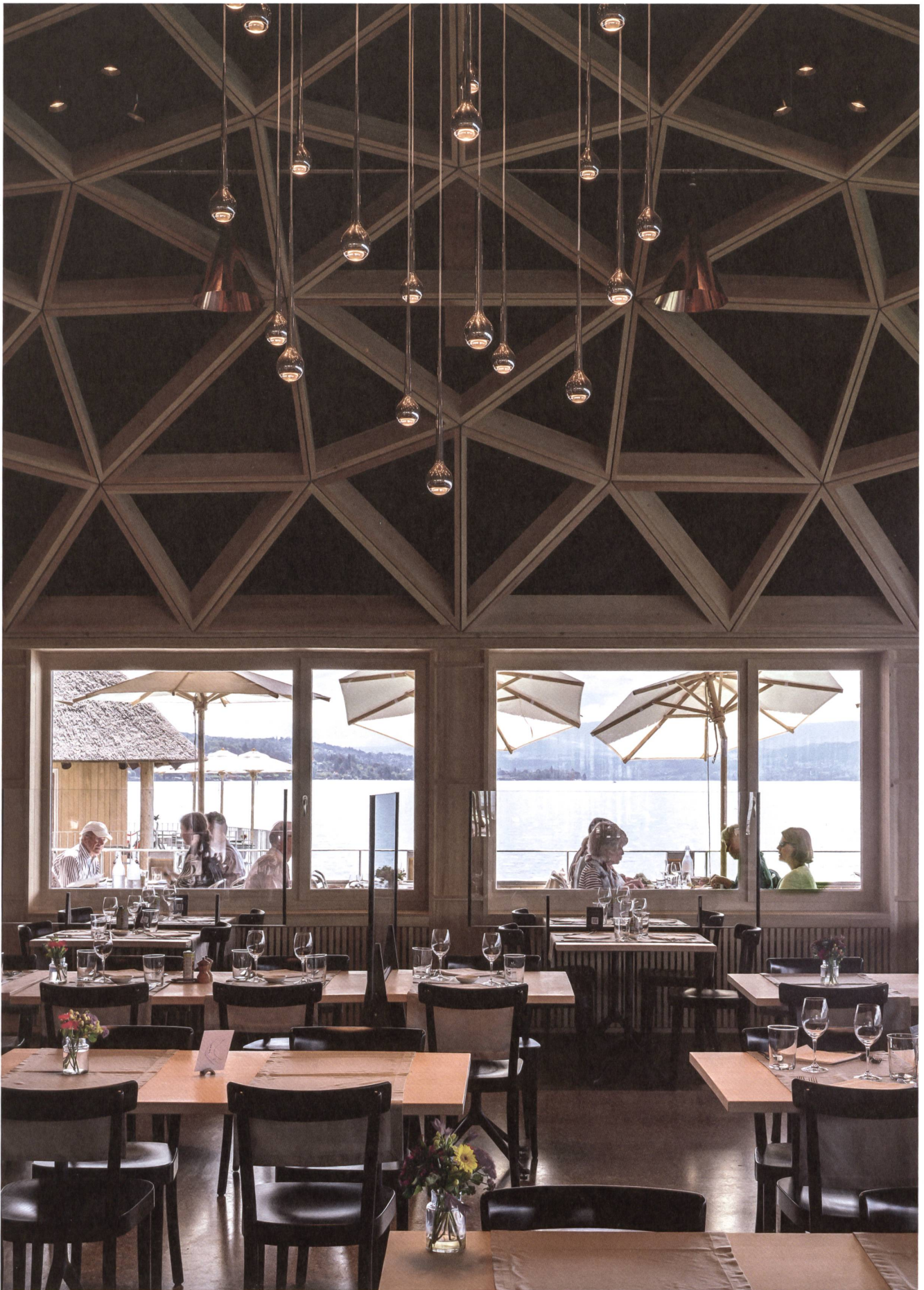
Spektakulär: Über dem Hauptsaal spannt sich ein Holzstabgewölbe, erdacht von «Geometrieingenieur» Urs B. Roth.
