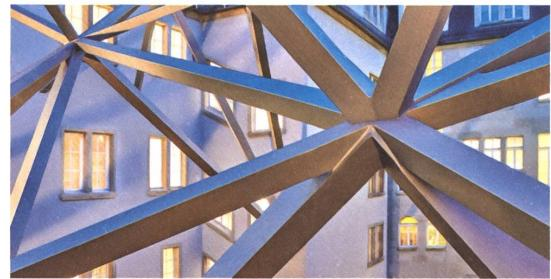
Das silbern schimmernde Stabwerk besteht aus quadratischen, dickwandigen Kastenprofilen aus verschweißten Blechen. | Le treillis argenté se compose de profilés creux carrés, en tôles soudées et de forte épaisseur.
