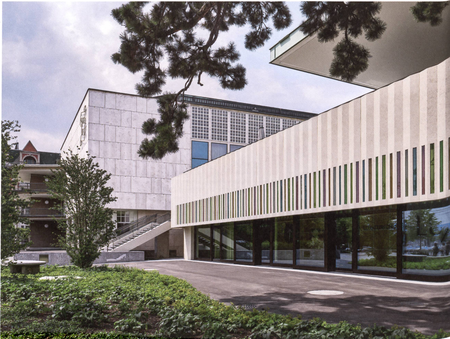
Der neue Gartentrakt steht quer zum markanten Kongresssaal von 1939. Der gefälte Betonsturz mit den farbigen Gläsern ist ein Werk von Josef Felix Müller.
