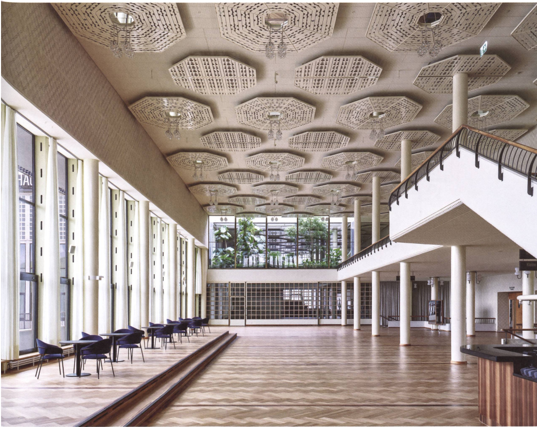
Das Tonhalle-Foyer ist einer der architektonischen Höhepunkte des Gebäudes. Es wurde sorgfältig saniert, die Leuchten hat man entsprechend den Originalen aus dem Jahr 1939 nachgebaut.
