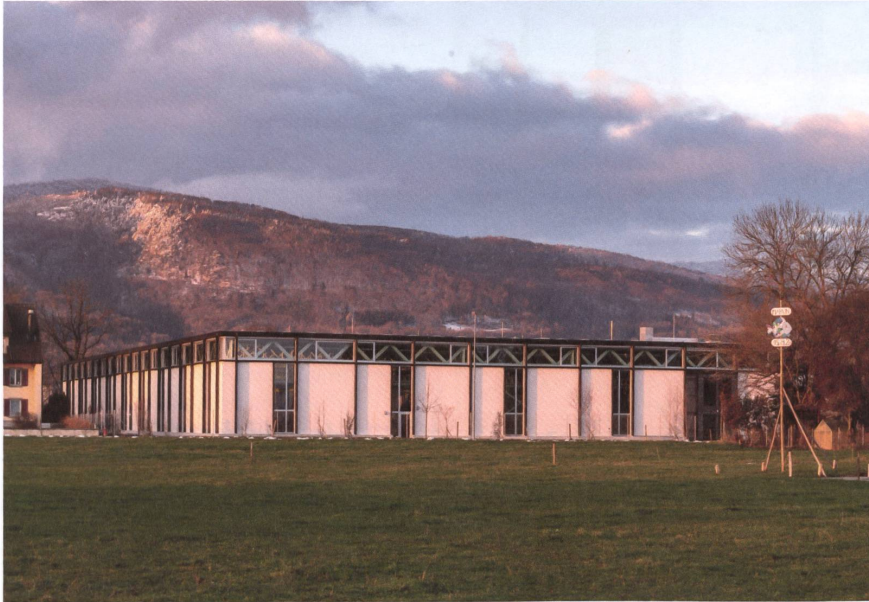
Das umlaufende Fensterband der Produktionsstätte in Härkingen macht das innen liegende Fachwerk sichtbar.
