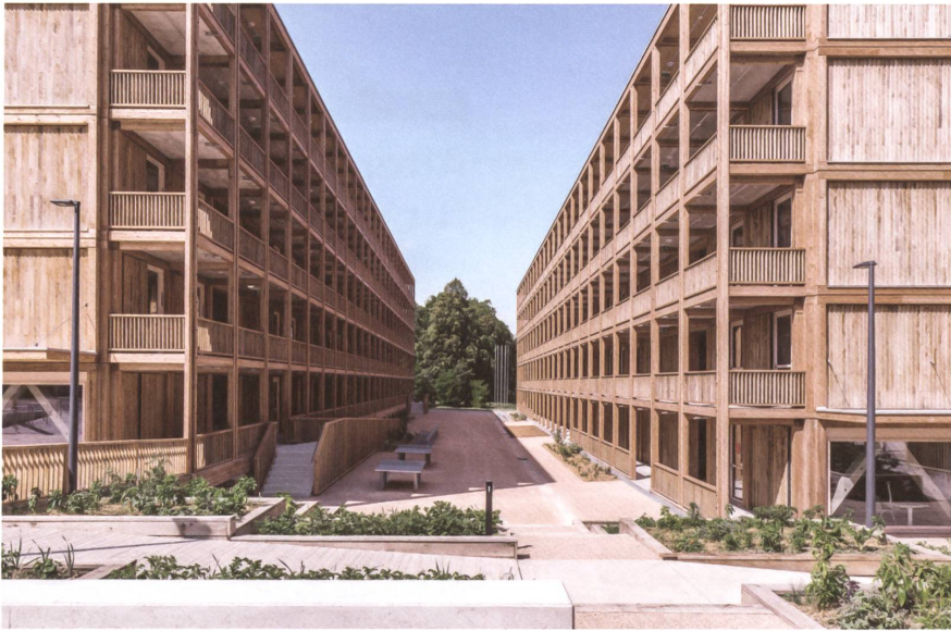
Für Paare, Familien oder Wohngemeinschaften lassen sich die Module der Flüchtlingsunterkunft Rigot in Genf verbinden. Im Erdgeschoss liegen Gemeinschaftsräume und Wohnungen für Menschen mit Einschränkungen.
