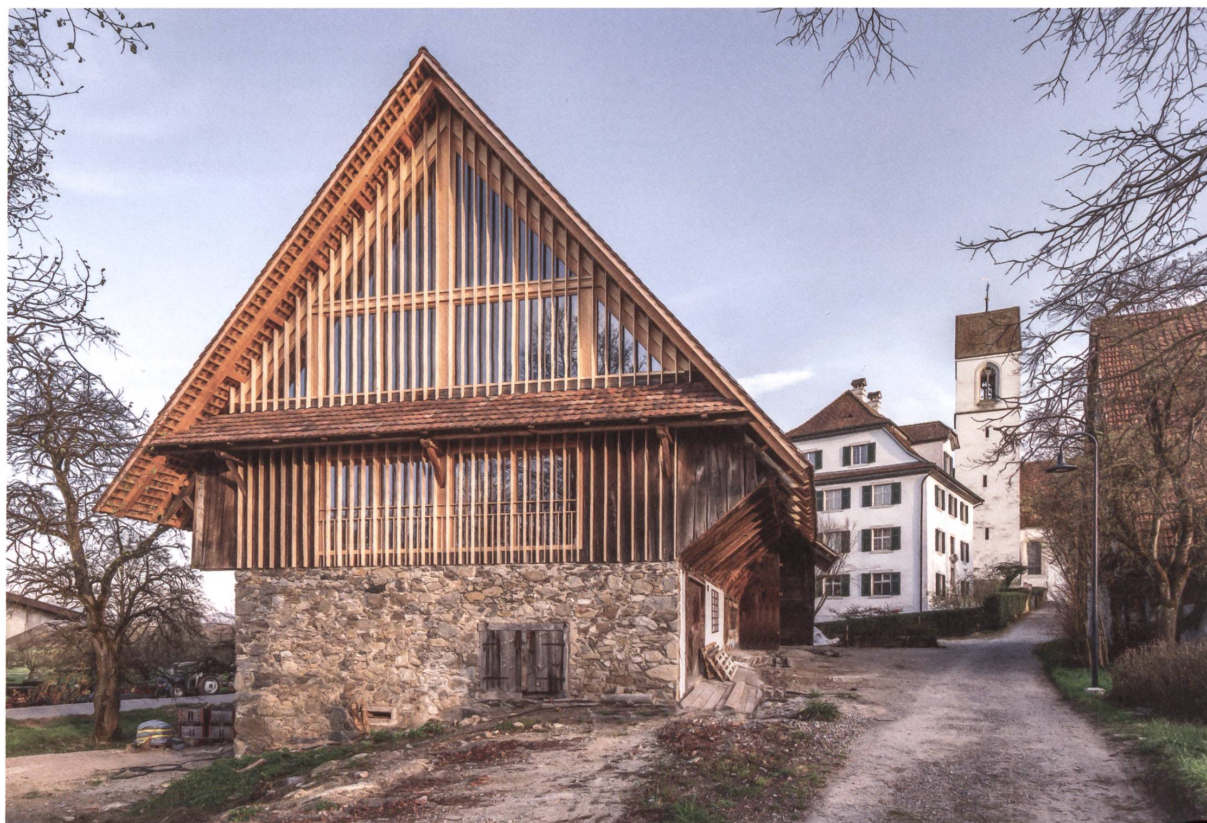
Flächen statt Löcher: Vor der fast vollverglasten Giebelfassade sorgen Holzlamellen für Ruhe und Einheit.
