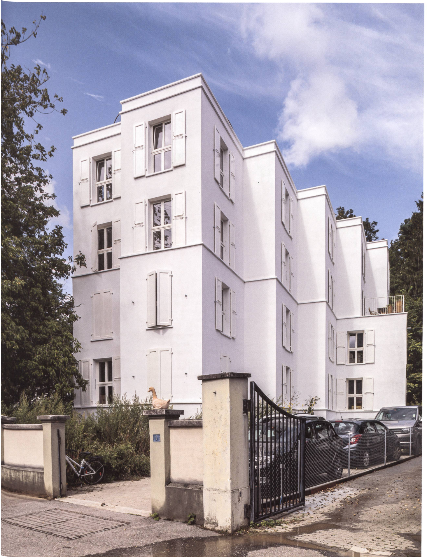
Aviolat Chaperon Escobar haben in Freiburg einen Altbau angebaut und aufgestockt. Vom Bestand ist nichts mehr zu erkennen.
