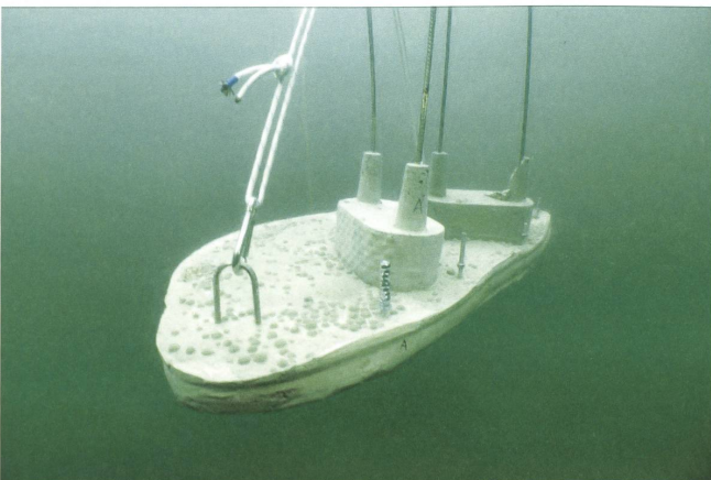
Schwere Betonplattformen bilden das Fundament des Riffs. Foto: André Fahrni
