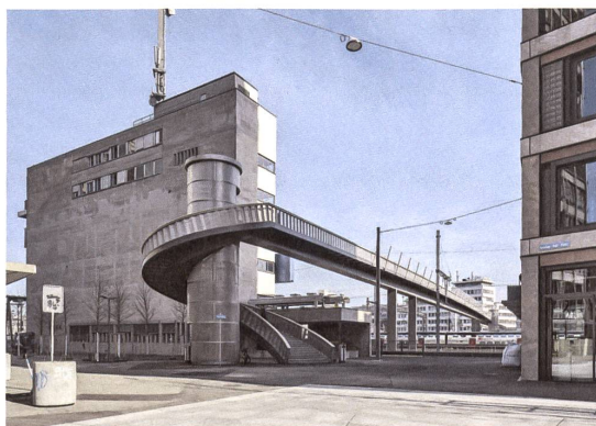
Die Runtreppen bei den Aufgängen sparen Platz.
