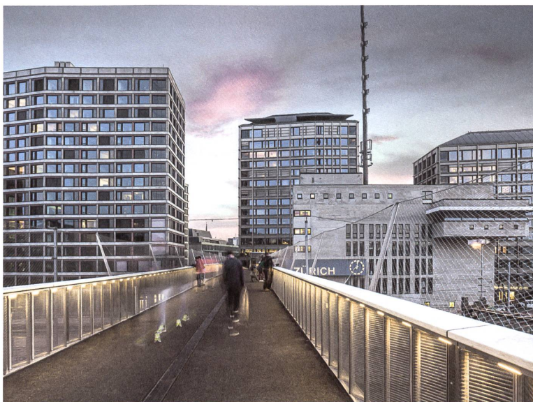
Der Negrellisteg verbindet die beiden Gleisseiten vor dem Hauptbahnhof Zürich.
