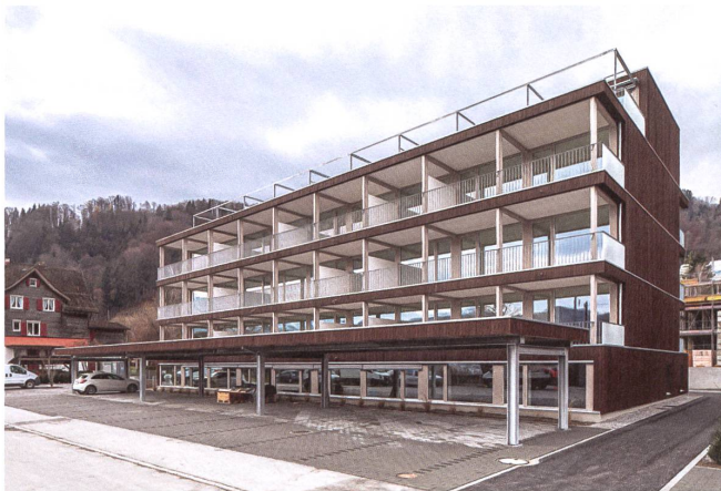
Pragmatisch präsentiert sich das Haus zur Strasse.
