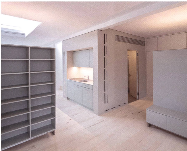
Die vorgefertigte Küchen-Bad-Box. Durch die Schlitze strömt die Luft zum Heizen oder Kühlen der Wohnung.
