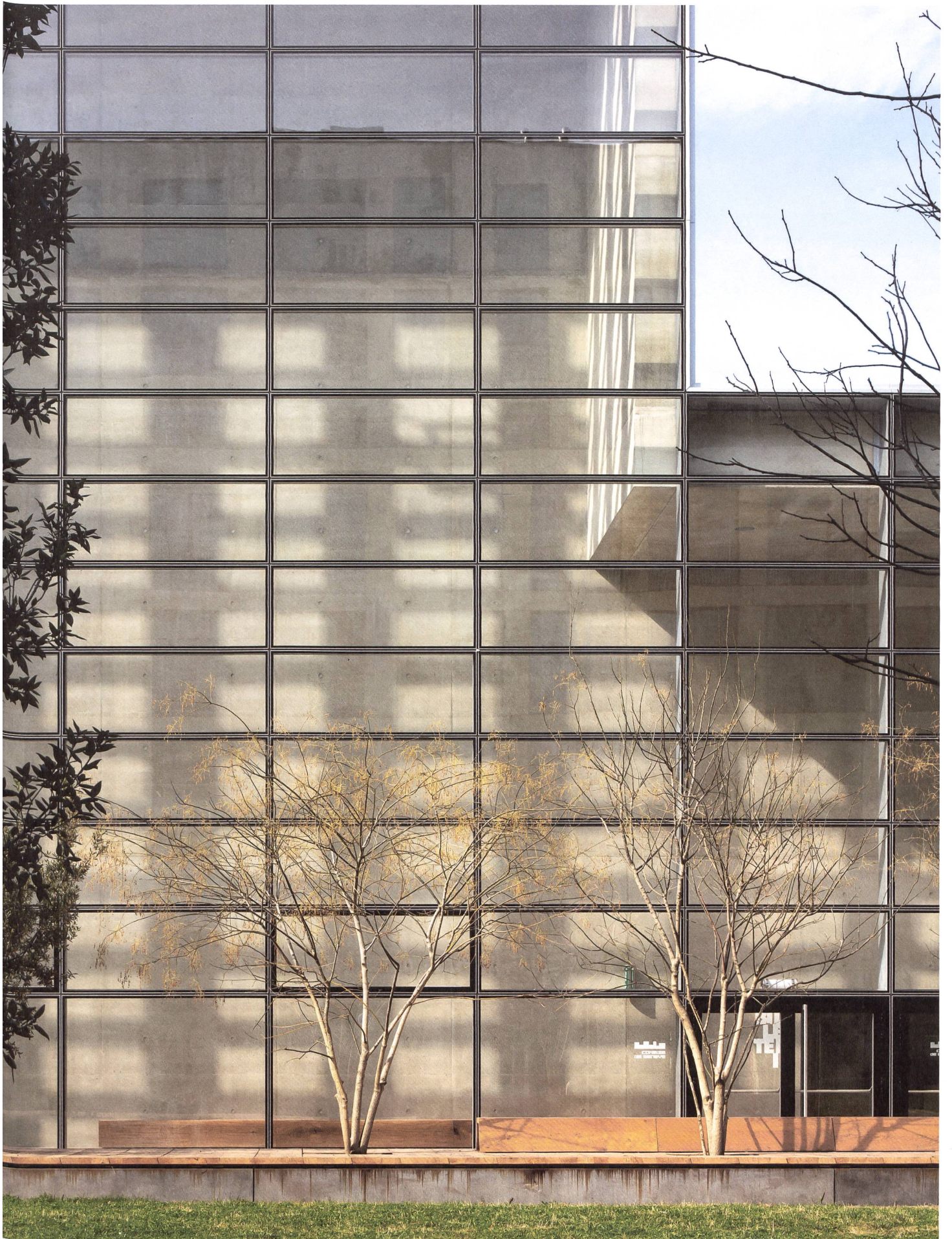
Der Fassadenraster des Theaters nimmt die Masse des Bahnhofs Eaux-Vives auf, der unter der Promenade Alice-Bailly liegt.
