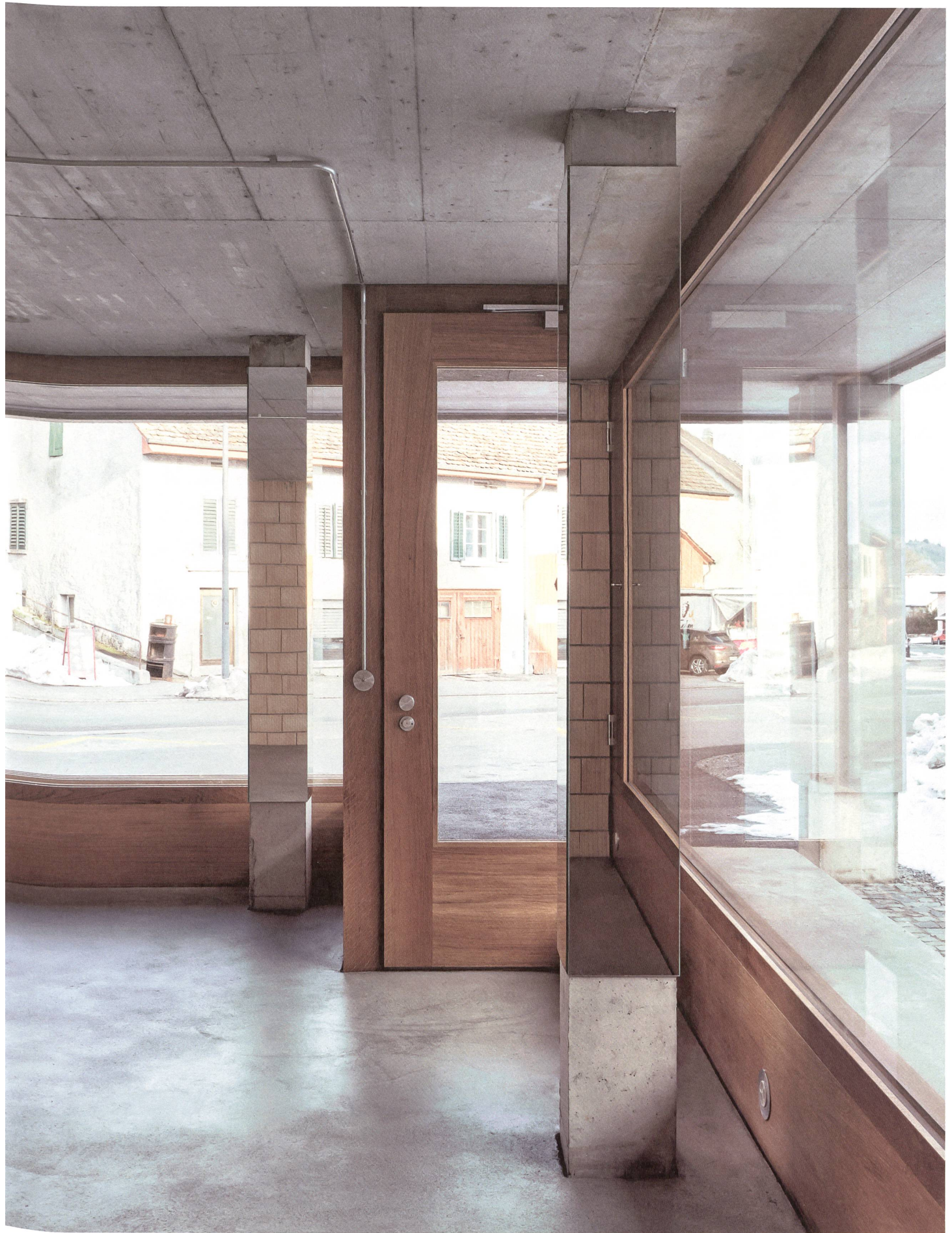
Eichenholz, Zementschliff, Spiegel und Glas prägen das Erdgeschoss. Im Sommer soll hier ein Hofladen einziehen.
