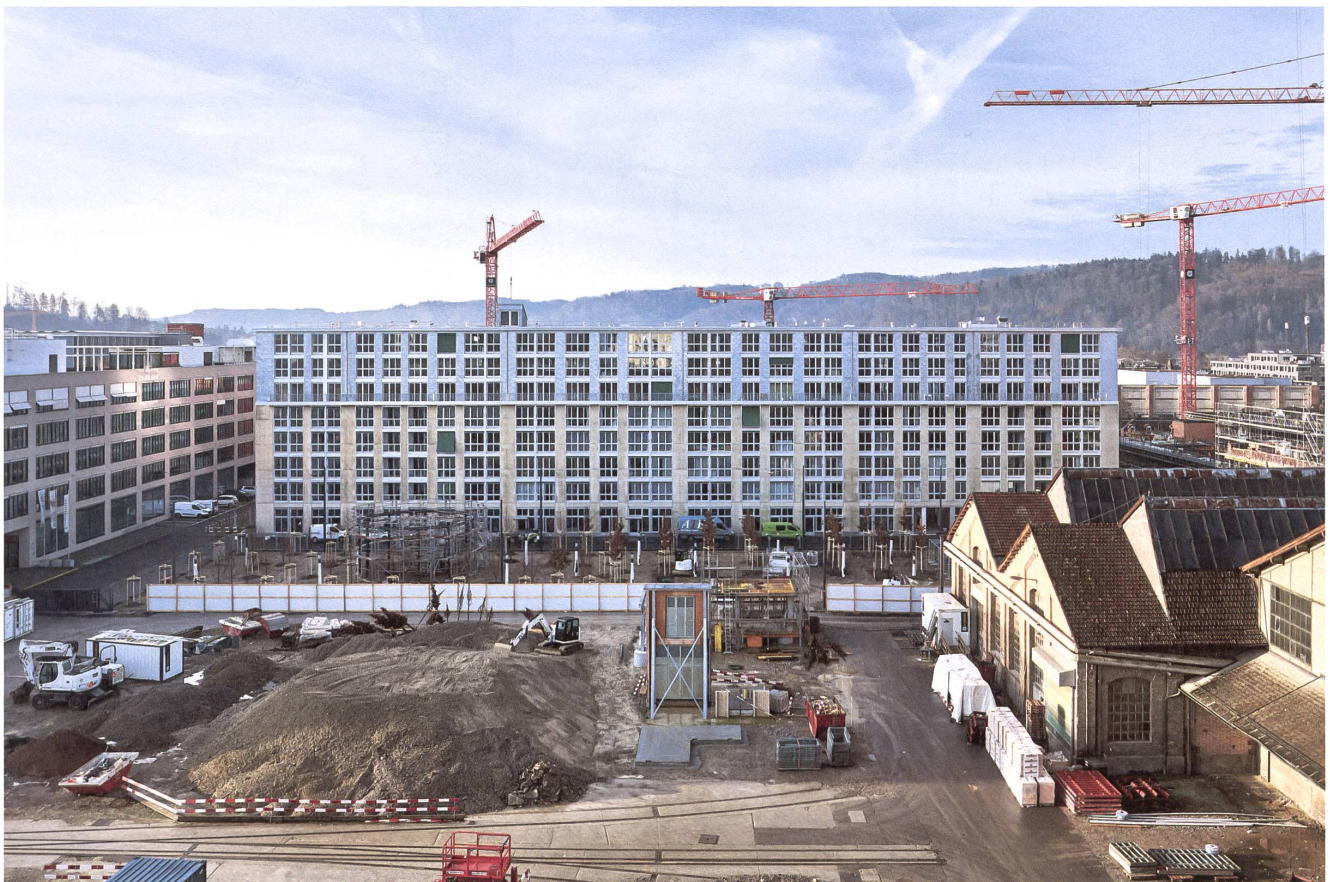
Auf dem Dialogplatz vor dem «Krokodil»-Gebäude wachsen reihenweise Bäume, rundherum wird noch an der «Lokstadt» gebaut.
