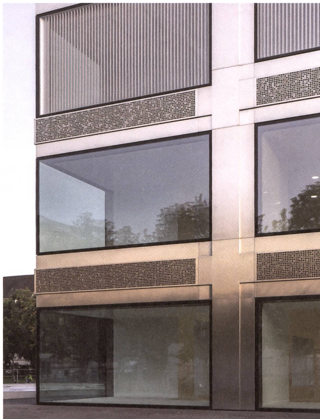
Die Kastenfenster sind fünf Meter breit und drei Meter hoch. Die Chromstahlverkleidung lässt das Gebäude in der Abendsonne golden leuchten.
