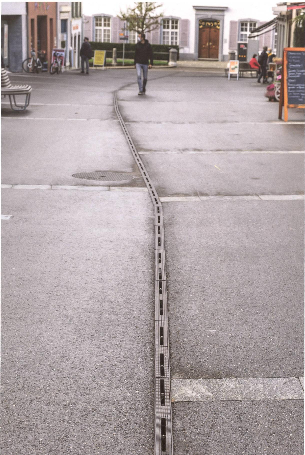
Zurückhaltend und multifunktional: Die Rinne sorgt für die Entwässerung und dient zugleich als Blindenführung. |
