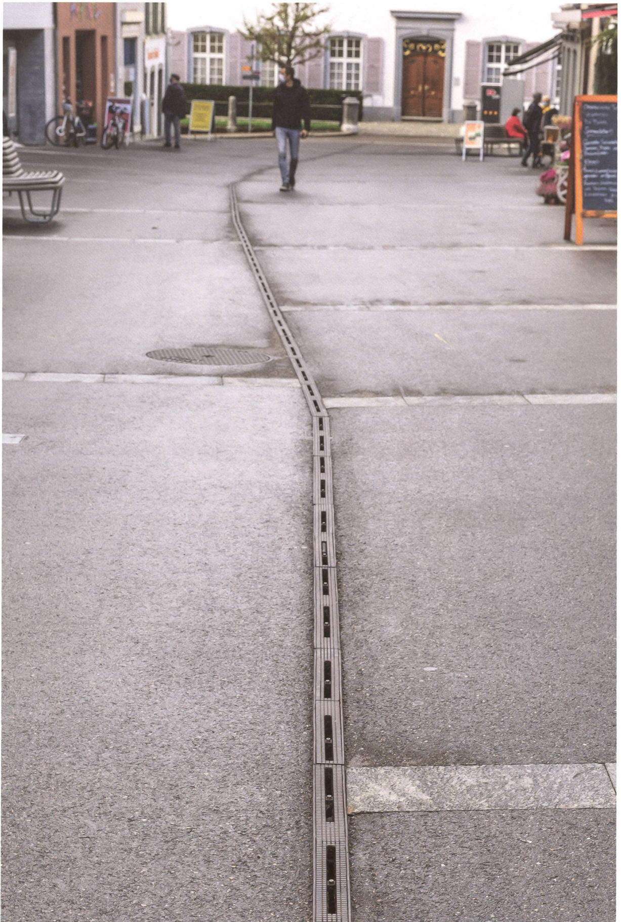
Zurückhaltend und multifunktional: Die Rinne sorgt für die Entwässerung und dient zugleich als Blindenführung. | Discret et multifonctionnel: le caniveau sert au drainage et en même temps à guider les aveugles.
