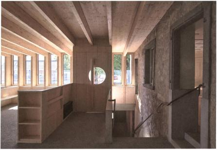
Innen ist fast alles aus Tannenholz gefertigt, der Boden ist aus Waschbeton. Foto: OLBH
