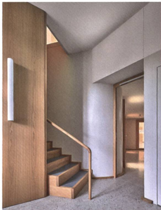
Eine neue Treppe führt ins 2. Obergeschoss.
