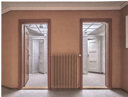
Die Toilettenanlagen mit den ursprünglichen Einbauten.
