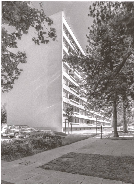
Tscharnerngut, Bern: Nur ein Verputzstreifen verrät, dass eine Raumschicht die Sechzigerjahressiedlung erweitert. | Tscharnerngut, Berne: Seule une bande de crépi révèle qu'il y a une extension du complexe résidentiel des années soixante.
