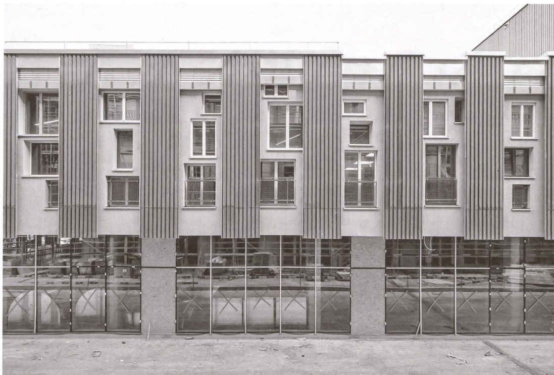
Kultur- und Gewerbehaus Lysbüchel, Basel: Zwischen dem Rhythmus alter Trapezbleche sitzen 200 Lagerfenster in den aus Abbruchholz geleinnten Rahmen. | Immeuble culturel et commercial Lysbüchel, Bâle: 200 fenêtres d'entrepôt sont insérées dans le cadre collé en bois de démolition et cassent le rythme des anciennes tôles trapézoïdales. Foto | Photo: Martin Zeller
