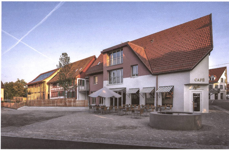
Zwei Neubauten flankieren den 200 Jahre alten, herausgeputzten Riegelbau in Winterthur.
