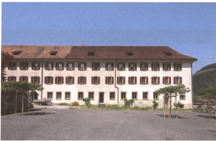
Das ehemalige Kapuzinerkloster Stans wird nach der Erneuerung zum «Culinarium Alpinum».
